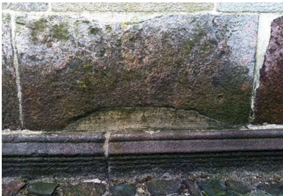
Vores landsbykirker fortæller, hvordan de op gennem tiden er brudt ned og sat sammen igen på nye måder efter behov. Granitkvadre som byggestene er yderst egnede til genbrug. Tolstrup Kirke, Brønderslev.
