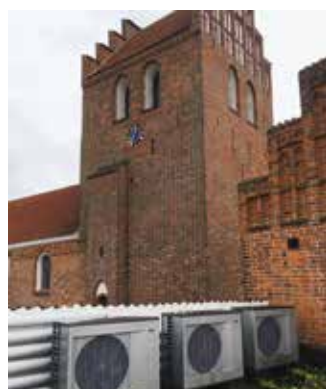
Foto 5: Køleaggregater til en luft-vand varmepumpe placeret udenfor kirkegårdsmuren
