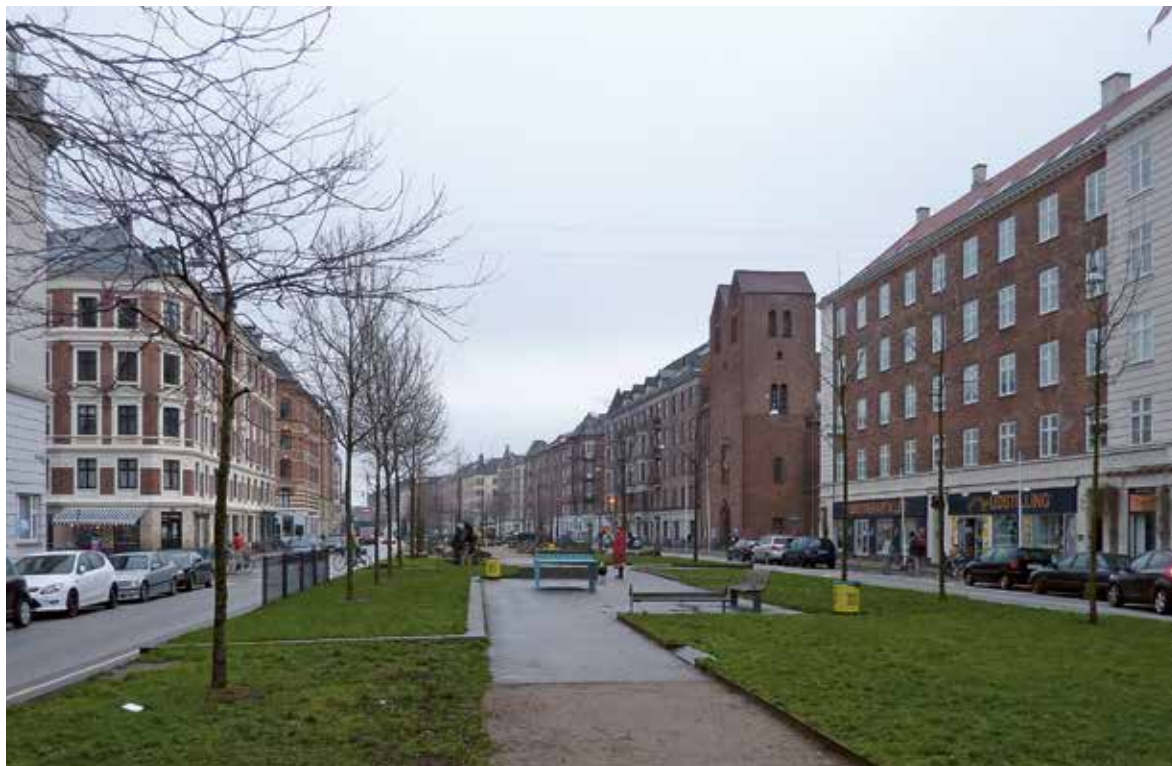
Absalons Kirke ligger ud til den nyligt renoverede Sønder Boulevard.
